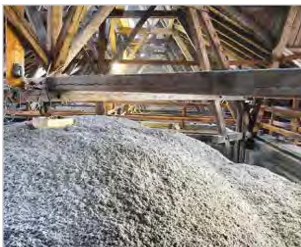
Die alte Isolierung über der Kuppel wird ausgebaut (oben) und mit einer neuen "Zellulose-Einblasdämmung" versehen
