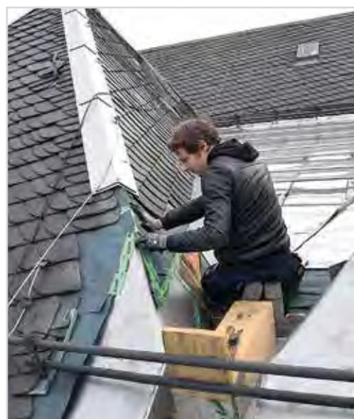
Die Dachkehlen werden abgedichtet
