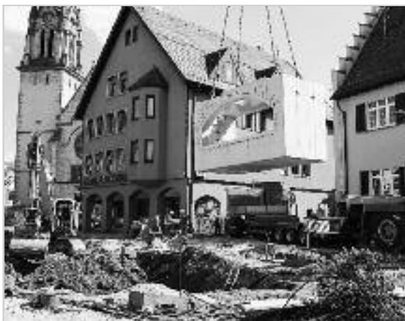
Das 17 Tonnen schwere Schacht-Bauwerk des neuen Primgewölbes (links) und weitere Schachtteile (rechts) werden mit einem Spezialkran versetzt.
