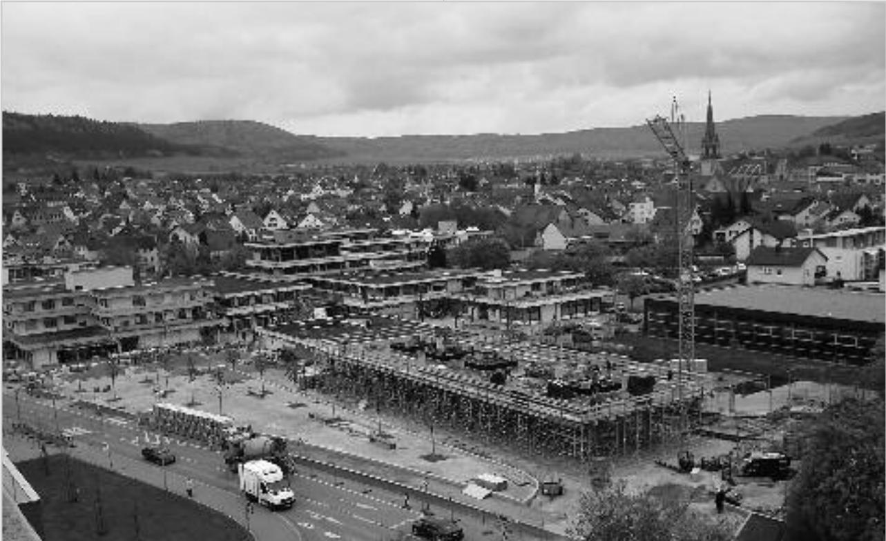
In der Bildmitte ist das noch im Bau befindliche „fliegende Dach“ des Busbahnhofes zu sehen. Für das Stahlbetondach 47,50 m lang, 12,0 m breit und ca. 5,10 m hoch war eine sehr aufwändige Gerüstkonstruktion erforderlich. Im Hintergrund das Rathaus und die neue Sporthalle der Rupert-Mayer-Schule.
