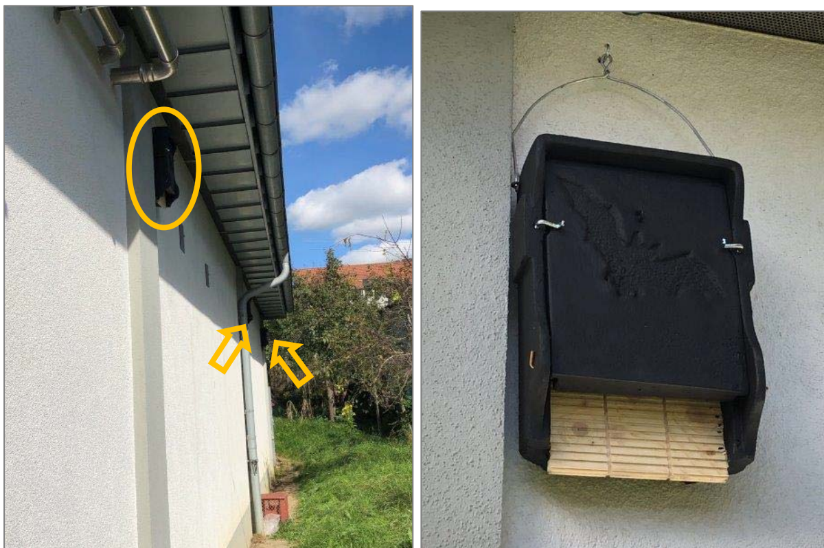
Abbildung 3: Fledermauskästen an der Ostfassade des verbleibenden Gebäudes Links: Übersicht der drei Standorte. Rechts: Detail Kasten 1FF (Fotos: L. Kaiser, Fa. Lidl, 30.09.2021)
