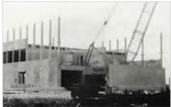
Frühjahr 1969: Betonfertigteile werden von der Firma Schwörer angeliefert und zusammengebaut
