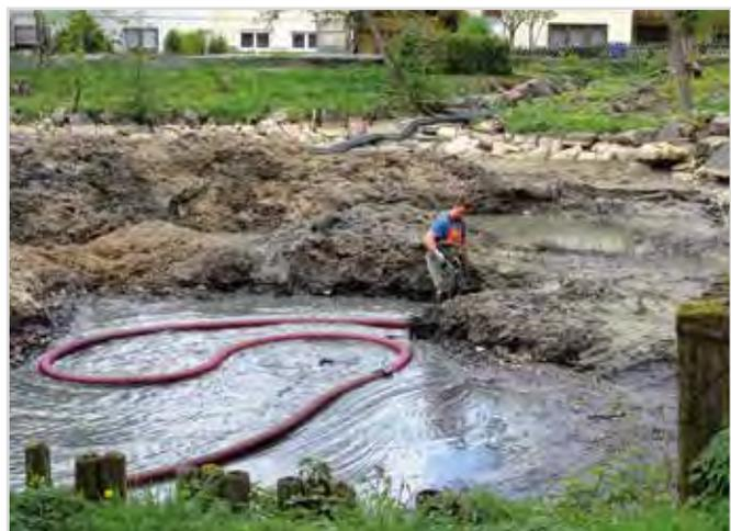
In einer sehr aufwändigen Aktion wird der Spaichinger Entteich vom Schlamm gesäubert. Ein kleiner Bagger lockert die Schlammmassen auf und unter schwierigen Bedingungen saugen Arbeiter mit speziellen Anzügen den Schlamm ab.
