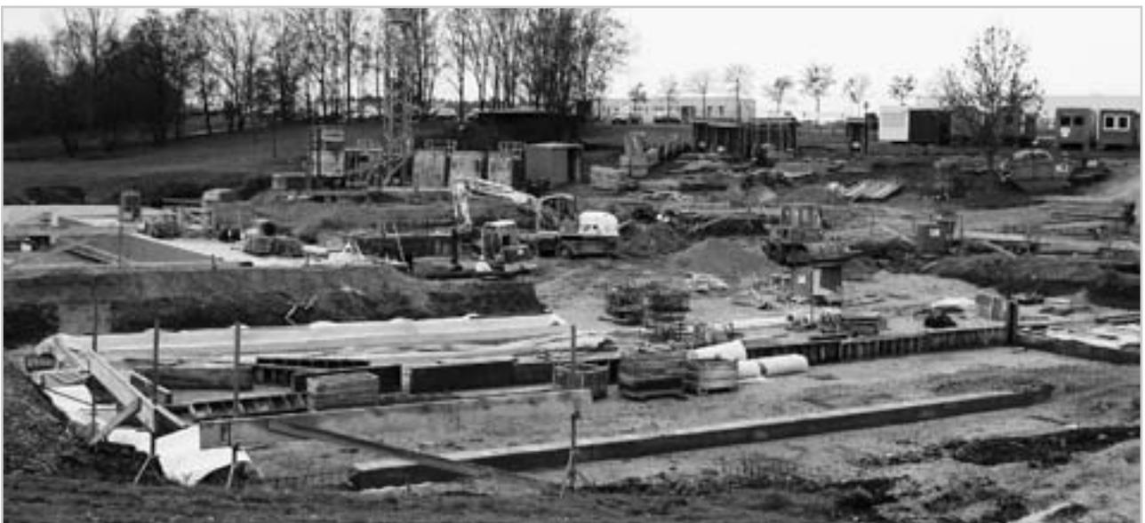
Das Freibad ist nicht mehr zu erkennen. Im Vordergrund werden die Fundamente für das spätere Nichtschwimmerbecken erstellt. In der Bildmitte wird an dem teilweise unterkellerten Schwimmmeistergebäude gearbeitet. Am linken oberen Bildrand sind bereits die Außenwände des Schwimmerbeckens zu erkennen.
