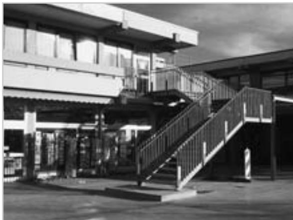
*Auf diesem Bild ist die neue Treppe Rathaus West zu sehen. Die bisher massive Betontreppe wurde komplett abgebrochen und durch eine filigrane Stahlkonstruktion ersetzt.*
