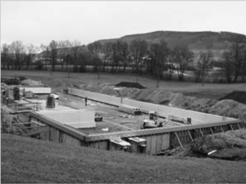
Die Außenwände des Schwimmerbeckens stehen. Der Boden im Becken fehlt noch. Im vorderen linken Bildbereich ist der künftige Sprungbereich zu erkennen. Am linken Bildrand ist der spätere unterirdische Schwallwasserbehälter mit ca. 300 m<sup>3</sup> Fassungsvermögen zu sehen.
