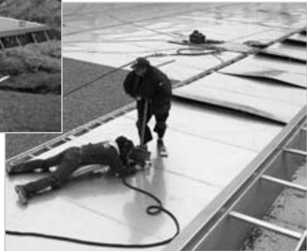
Eine Spezialfirma erstellt die hochwertigen Edelstahlbecken. In der Bildmitte sind die Wassereinströmkänäle zu erkennen, über die später das aufbereitete Wasser in die Becken von „unten nach oben“ einströmt. Das Wasser in den Becken überläuft in die Schwallwasserinnen, die am Beckenrand die Becken einfassen.
