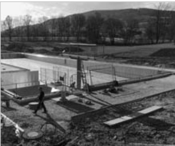
Das Schwimmerbecken mit der Sprunganlage ist fertig. Die Vorarbeiten für die Pflasterflächen am Beckenrand sind abgeschlossen.
